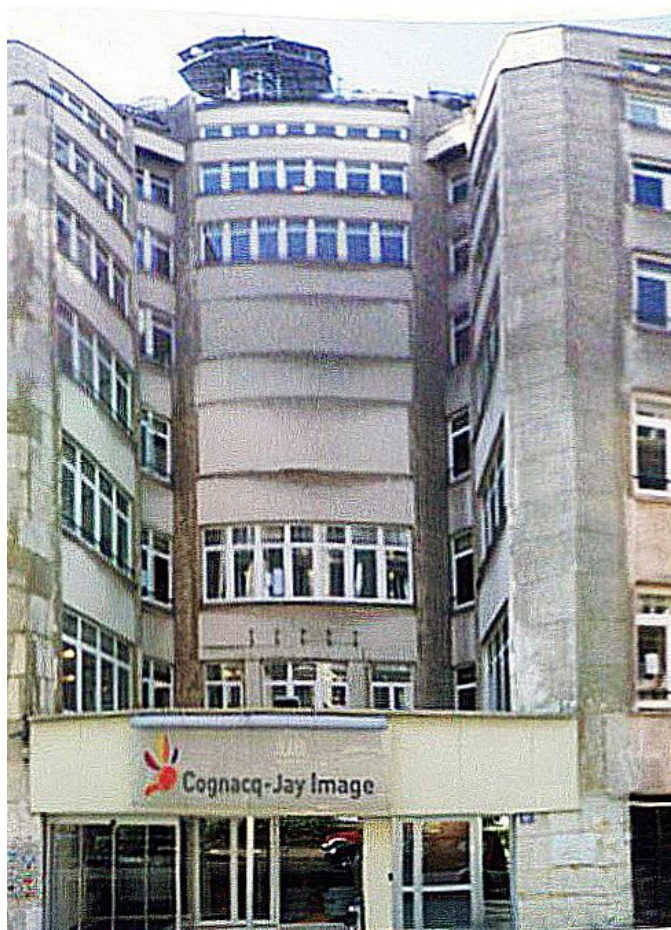
Le centre de télévision de Cognacq-Jay en 2012. Sur la terrasse du bâtiment une plateforme supporte les antennes paraboliques satellites et faisceaux Hertzien nécessaires à l'exploitation du centre
